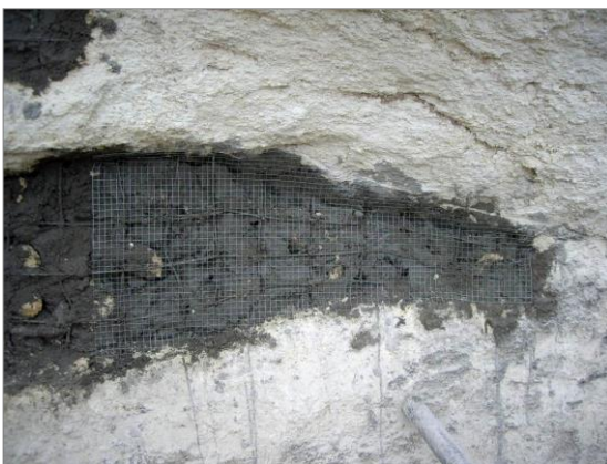
Слика 2. Израда подлоге за вештачки камен, постављање анкера и рабиц плетива
