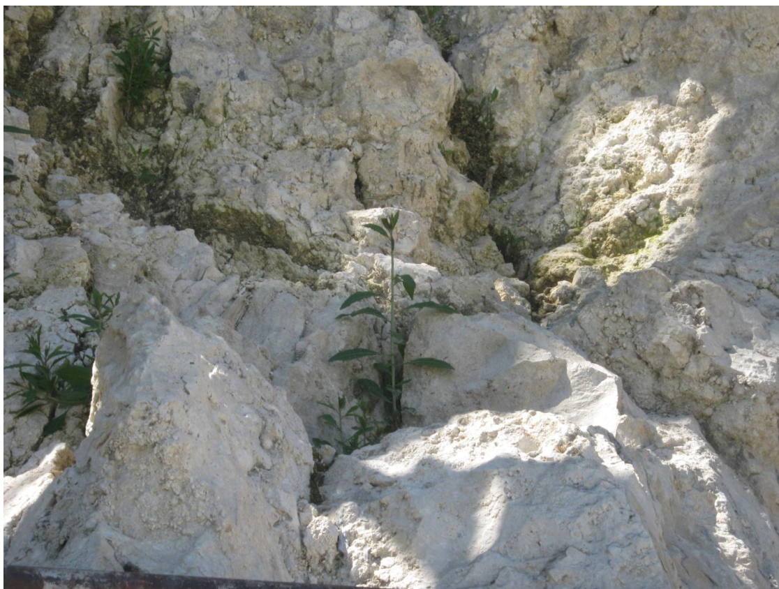
Слика 7. Појава растиња након извршене конзервације стене
