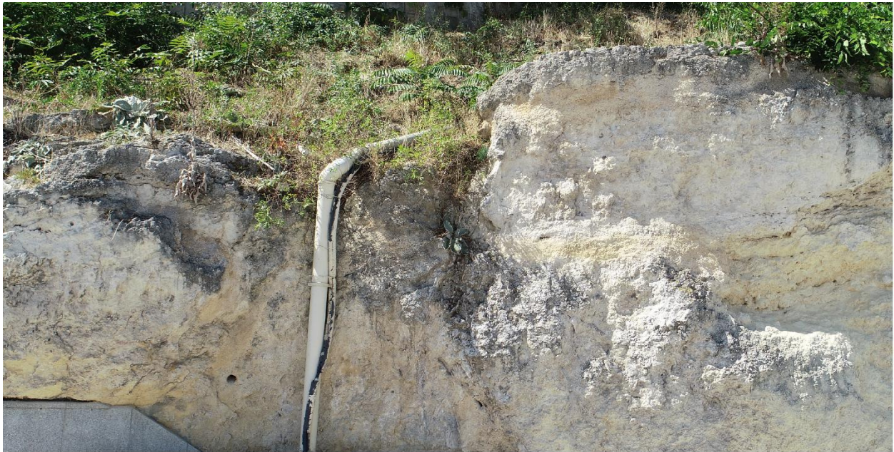
Слика 50. Сегмент 3 – промене на централном делу уз таложење органске материје и раст вегетације
