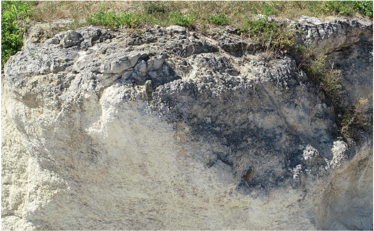
Слика 63. Врх сегмента 5 – распадање стене и промена боје
