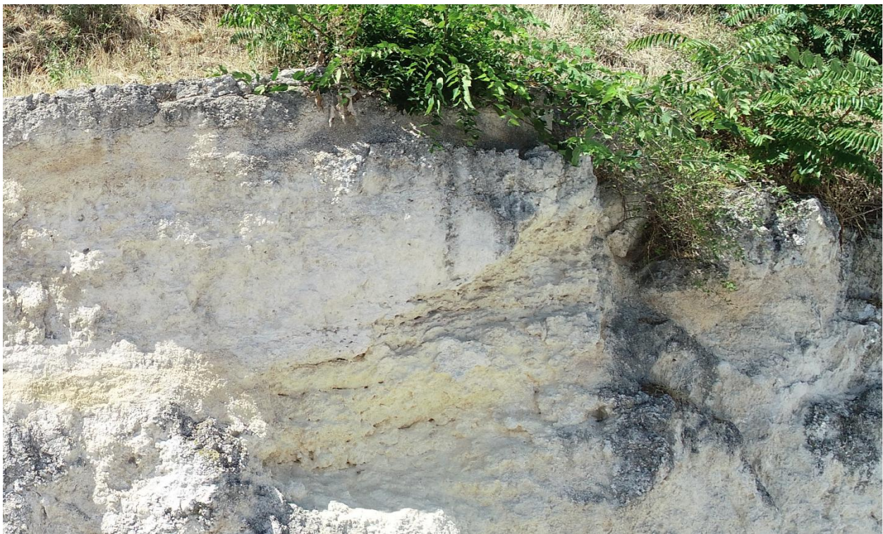
Слика 51. Сегмент 3-4 промене боје уз таложење органске материје и раст вегетације
