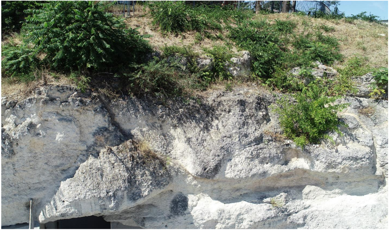
Слика 57. Сегмент 4 – Пукотине и вегетација у горњем делу
