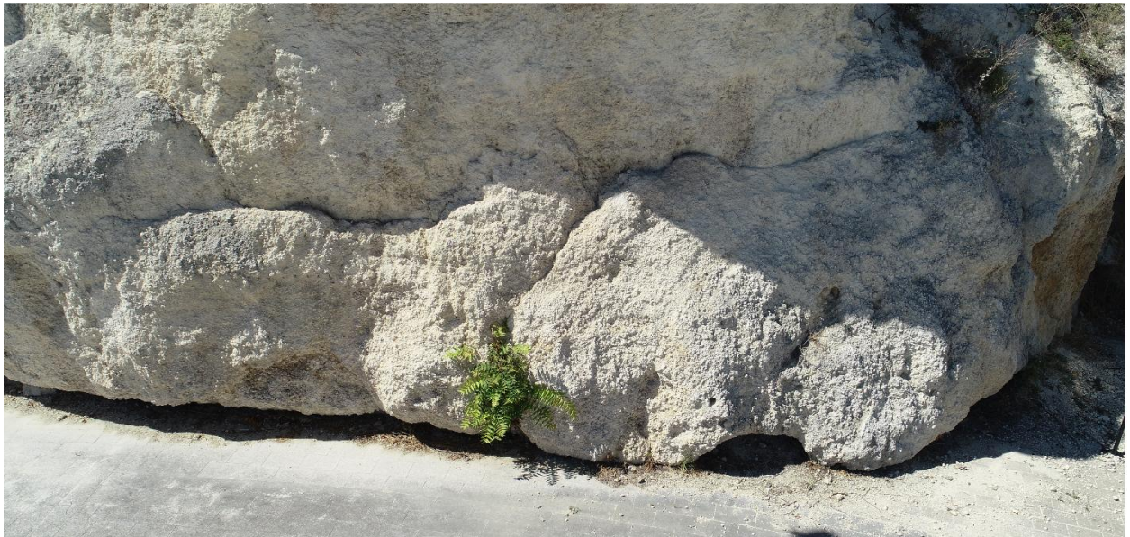
Слика 58. сегмент 4. доњи део, појава вегетације у путини
