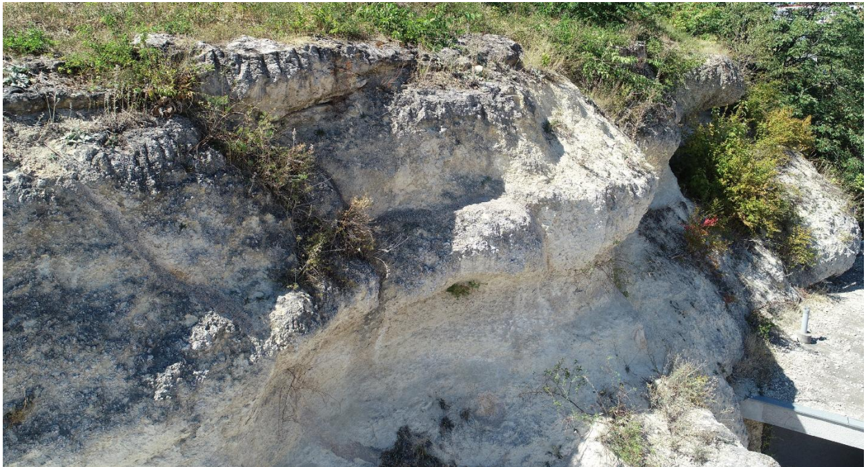
Слика 70. Сегмент 6 - избочина и појава вегетације
