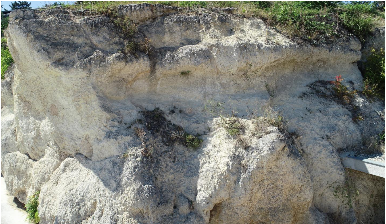
Слика 68. Сегмент 6 - избочина са појавом вегетације
